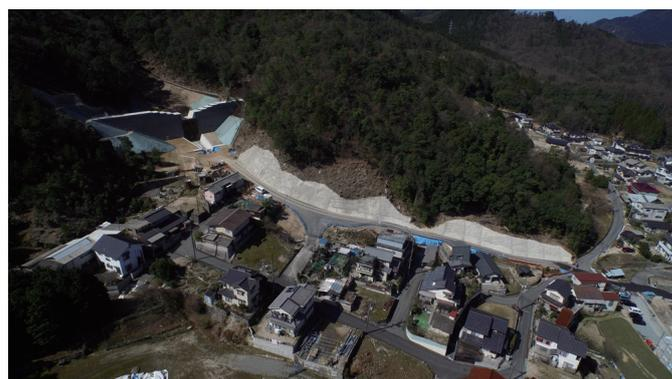
石丸川(桐原)に建設された砂防堰堤
