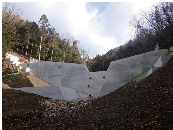
谷尻川(深川)に建設された砂防堰堤
