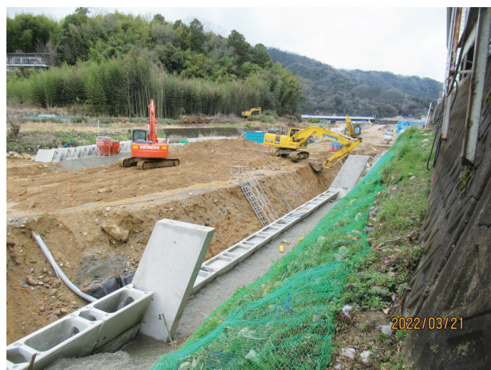
三篠川第4工区(白木町高南) 河川の拡幅と河床引き下げ工事
